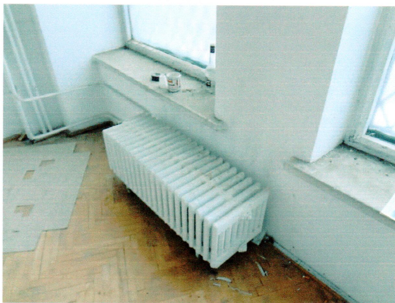
Figura 3. Corpurile statice nu au fost spălate de cel puțin 3 ani și majoritatea elementelor de reglaj sunt nefuncționale
