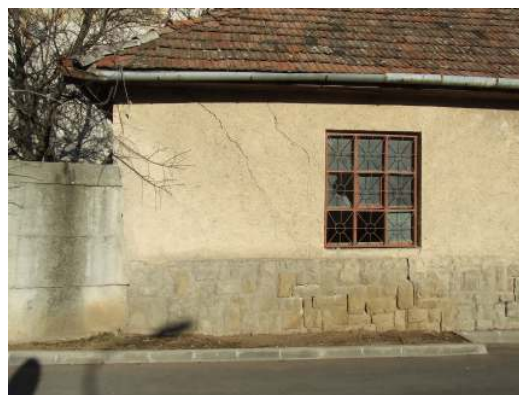
Crapaturile pe coltul vestic al corpului C5, cu jhgeabul pluvial defect, in stanga dupa gard cu copacul langa fundatie
