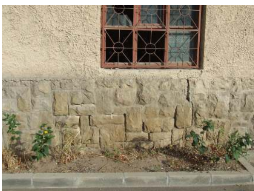
Zona de pornire a crapaturilor de pe coltul vestic al corpului C5, din exterior
