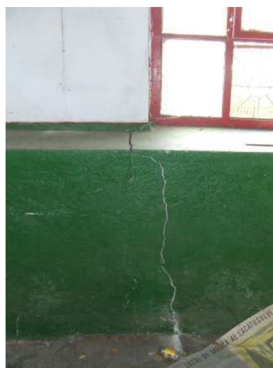
Zona de pornire a crapaturilor de pe coltul vestic al corpului C5, din interior
