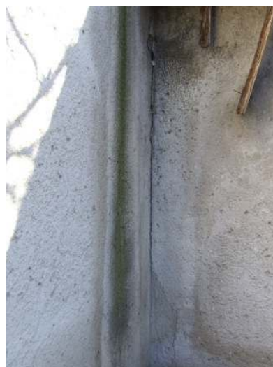
Zona de pornire a crapaturilor de pe coltul vestic al corpului C5, din interior
