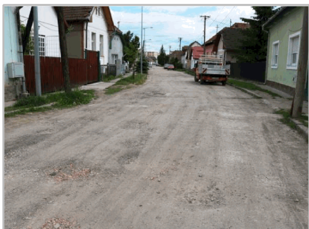
Figura 2.31. Străzi din beton în stare degradată (Str. Puskas Tivadar, Str. Tancsics Mihaly).
